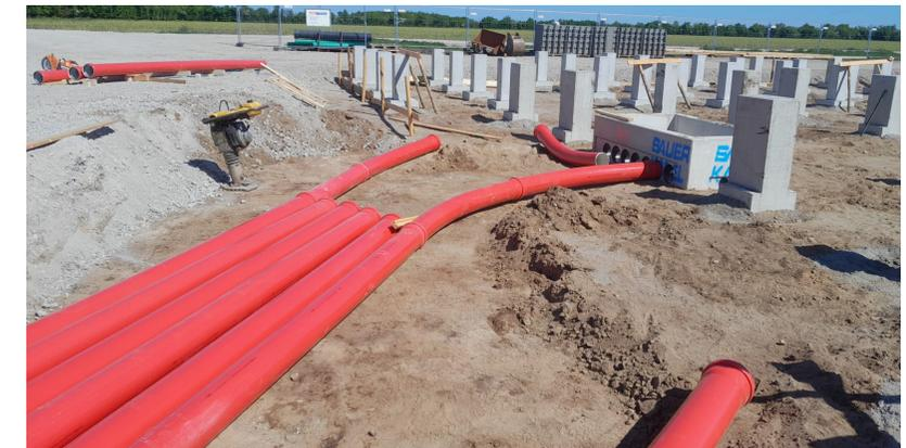
KG2000 e-line Kabelschutzrohre und Formteile im Einbau. Quelle: Hoff Tiefbau
